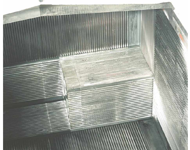
Abb. 2: Schleißblechauskleidung des Presskastens einer Paketierpresse Typ Rapida III-44
